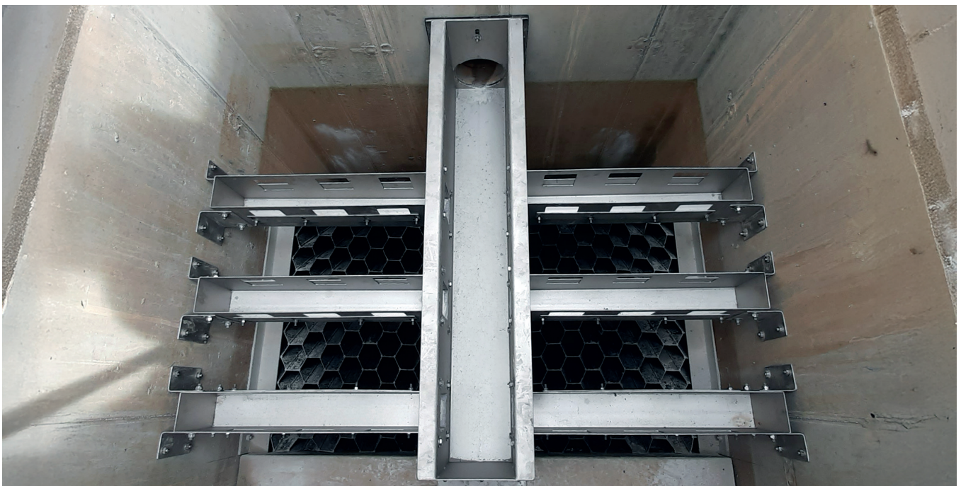
Einbaubeispiel eines Schrägklärers für einen Durchfluss von max. 16 l/s
