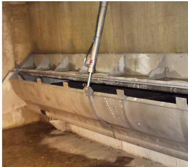
Bild 3: RÜ-Stauklappe SG, 4-seitig dichtend
