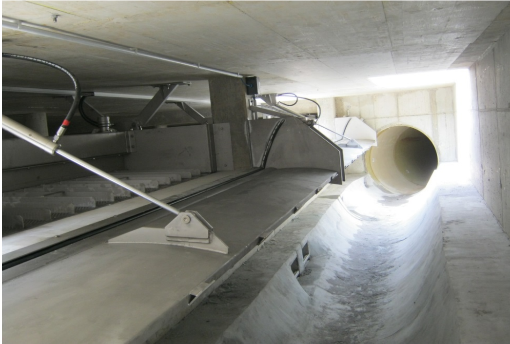
Bild 1: RÜ-Stauklappe SG in Kombination mit RÜ-Feinsiebrechen
