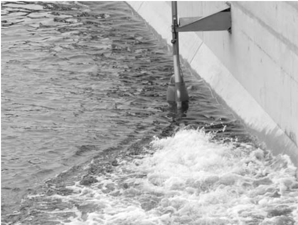
Bild 3: Der bgu-Schwenk-Strahl-Reiniger im Einsatz
