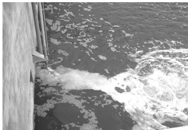
Bild 2: Der bgu-Schwenk-Strahl-Reiniger bringt Bewegung ins Becken
