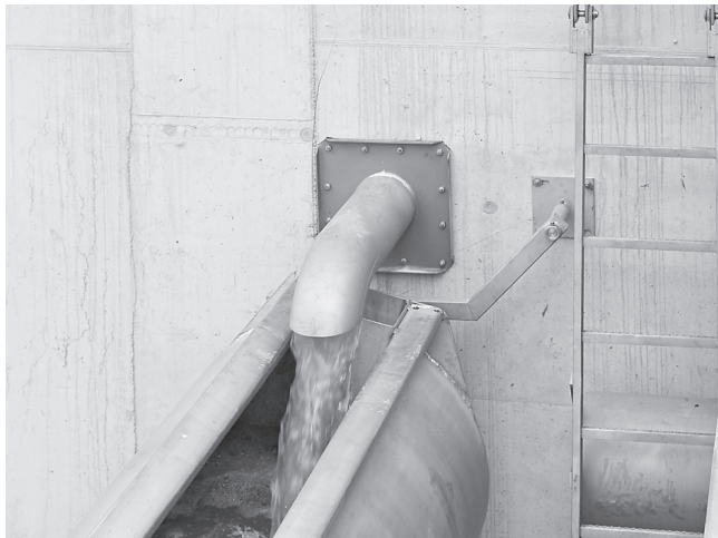
Bild 3: Schwall-Spül-Trommel befüllt (Typ B) während Befüllungsvorgang
